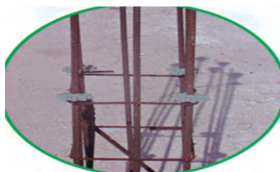
COLOCACIÓN EN PILARES
