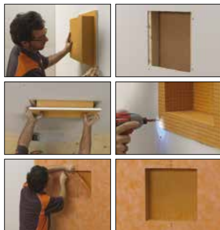
Instalación con paneles de cartón yeso:
