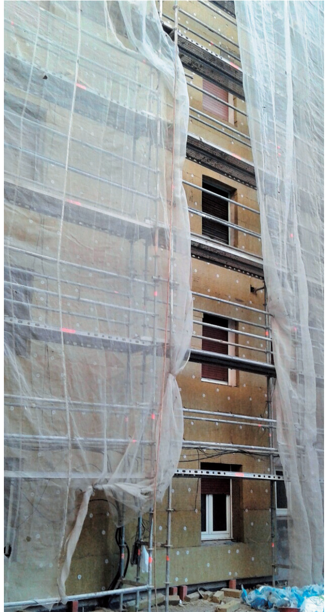
Figura 1. Obra de instalación de un sistema SATE
