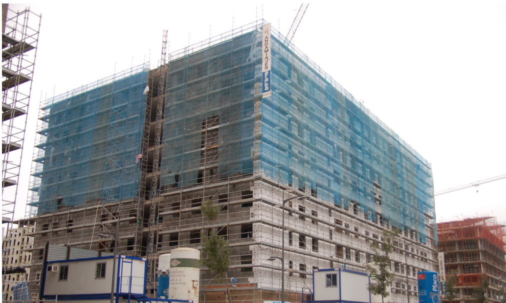
Figura 1. Obra de instalación de un sistema SATE
