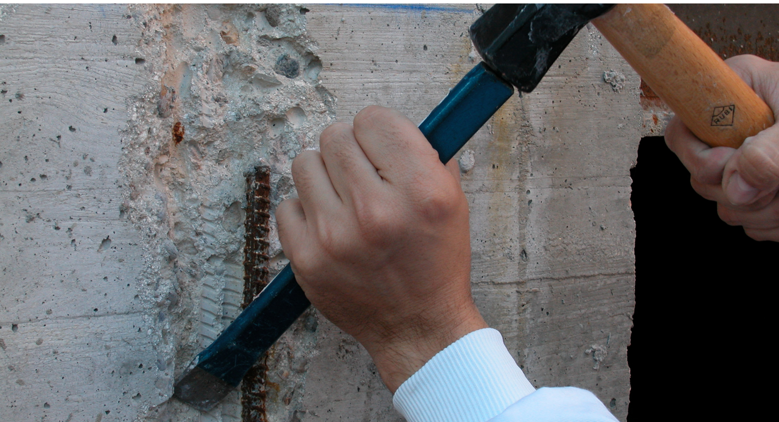
Figura 2. Preparación de la superficie a reparar
